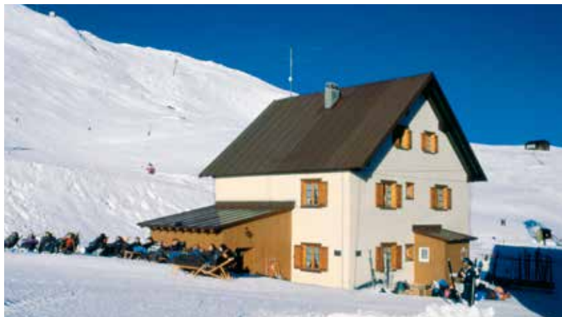
Das erste, noch als Testobjekt geführte Gebäude mit Sto-WDVS steht in alpiner Umgebung und bringt wertvolle Erkenntnisse zu Langzeitverhalten und Effektivität.
