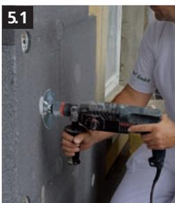
**5.1** Die neue Dämmplatte wird durch das vorhandene WDVS verdübelt. (mit Rondelle)
