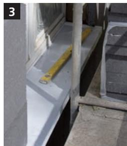
**3** Mit der Montage des neuen Dämmsystems müssen die Fensterbänke und Anschluss-elemente erneuert werden.
