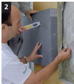
**2** Zur Beurteilung der Standsicherheit und Tragfähigkeit wird das vorhandene WDVS an mehreren Stellen geöffnet.
