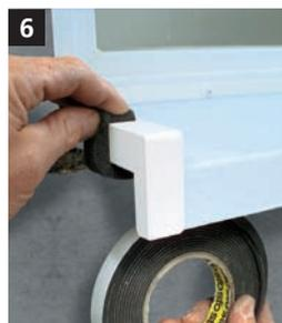
**6** Die Anschlüsse an systemfremde Bauteile werden gesetzt.
