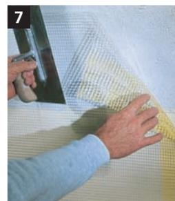
**7** Es erfolgt die Bewehrung der Dämmplatten mit dem eingebetteten Glasfasergewebe.
